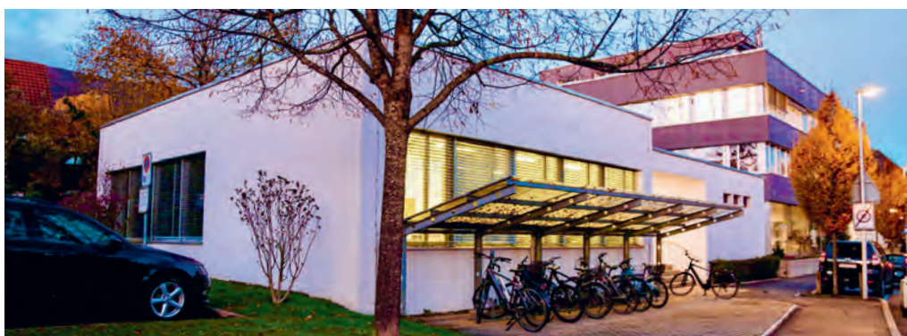
Die Musikschule in der Dämmerung – Anbau West des Gemeindehauses.
